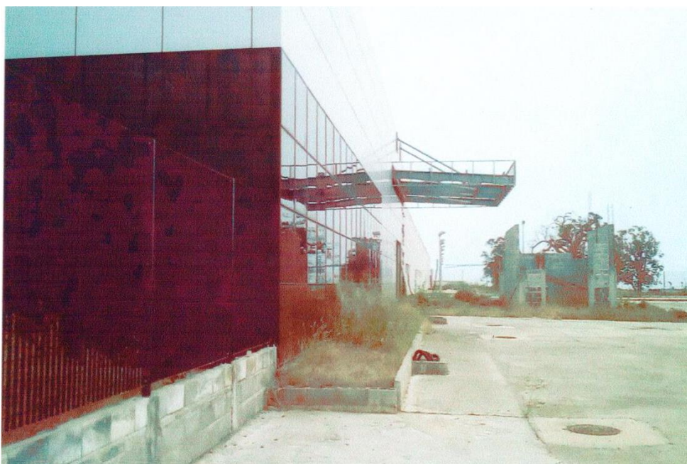
Chantier de l'hôpital général de Loango en arrêt depuis 2016. Photo de 2019. Crédit photo, CDJP Pointe Noire
