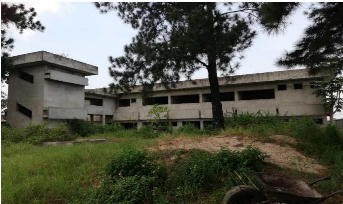
Chantier de construction de l'Hôpital de base de Ouenzé (Ex CNSS), en arrêt depuis 2012. Photos du 18 mars 2019. Crédit photo CDJP Pointe Noire
