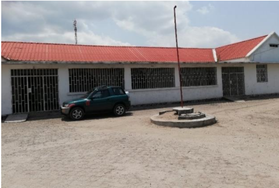
Réhabilitation du CSI Jane Vialle de Ouenzé, en arrêt depuis 2015. Photo de 2019, Crédit photo CJP Pointe Noire
