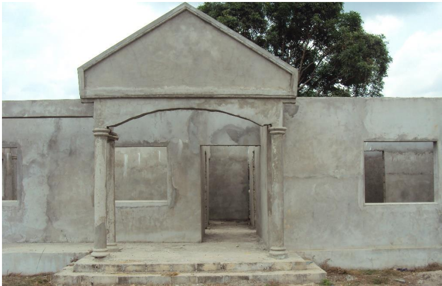
Logement de médecin du DS d'Ewo, photo de 2019. Crédit photo CJP Pointe Noire
